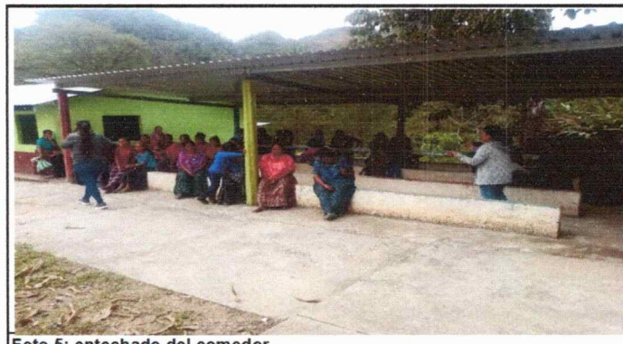
Foto 5: entechado del comedor
