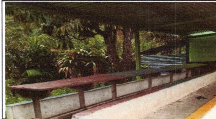
Foto 3: colocacion piso azulejo a al mesa de cemento
