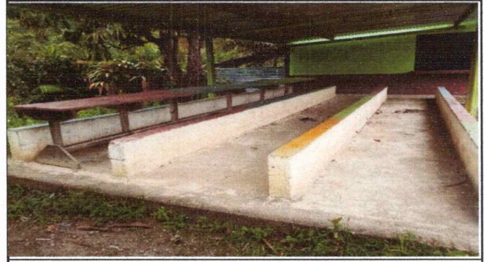
Foto 2: reparacion de las 2 mesas de madera a meclaz de cemento
