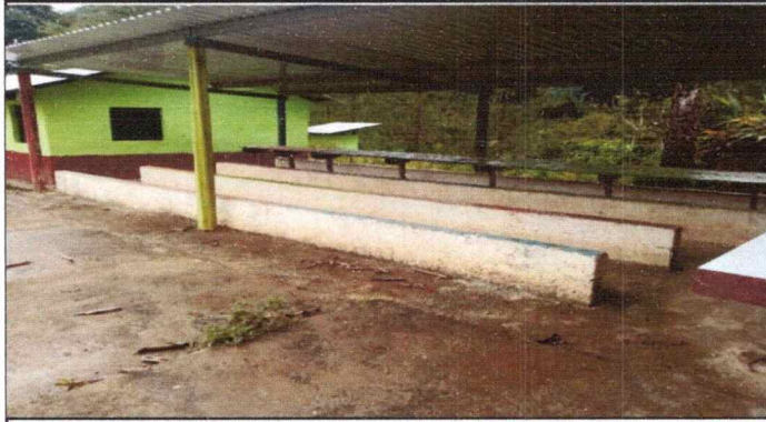
Foto1: cubierta de bloq del comedor
