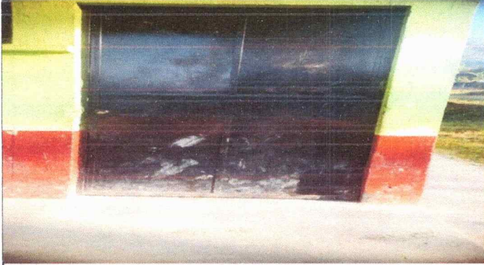
Foto1: mantenimiento de puertas
